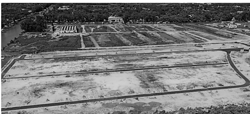
Area donde se construirá Villa Marina II. Se observa el desmonte de la vegetación. (foto http://www.vilamarina.com.ar/vila_marina2.html )
