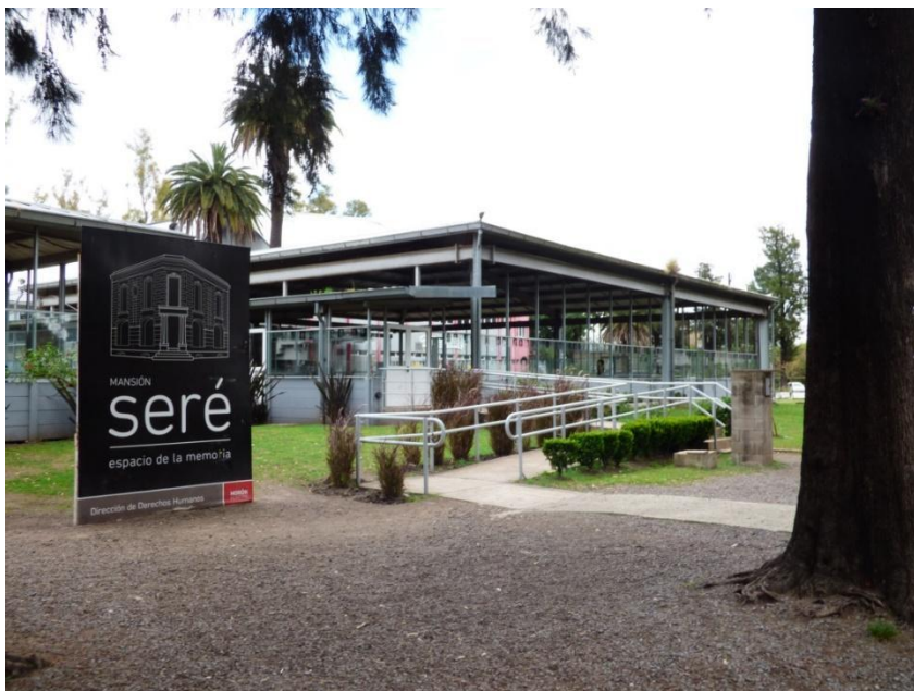
Fotografía N°1, vista del ingreso al EMS. Fuente, fotografía tomada durante trabajo de campo el 13 de septiembre de 2017.
