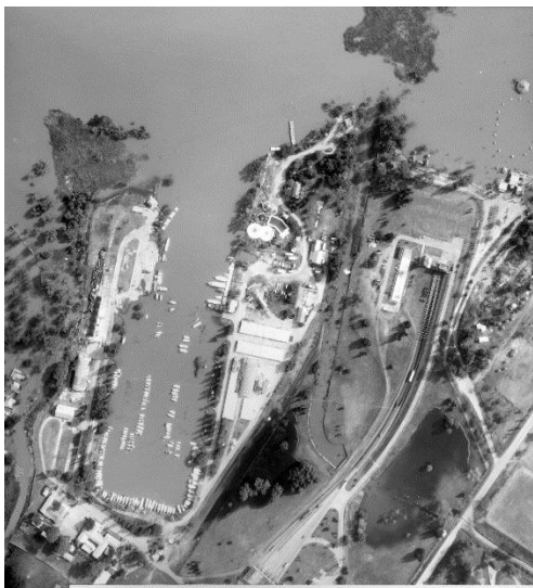
Obrador del Túnel – Dique Seco - convertido en Caleta del Club Náutico. Fotografía aérea, 1991. Escuadrón Aerofotográfico II Brigada Aérea con asiento en Paraná.
