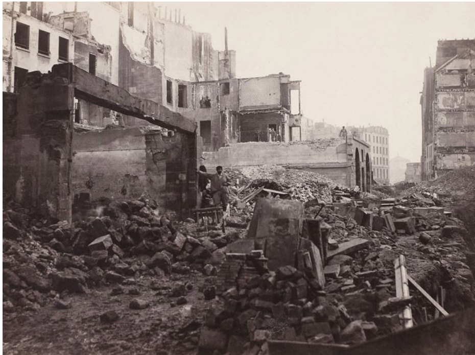
Marville, Charles. Construcción de la Avenida de la Ópera. Diciembre de 1876
