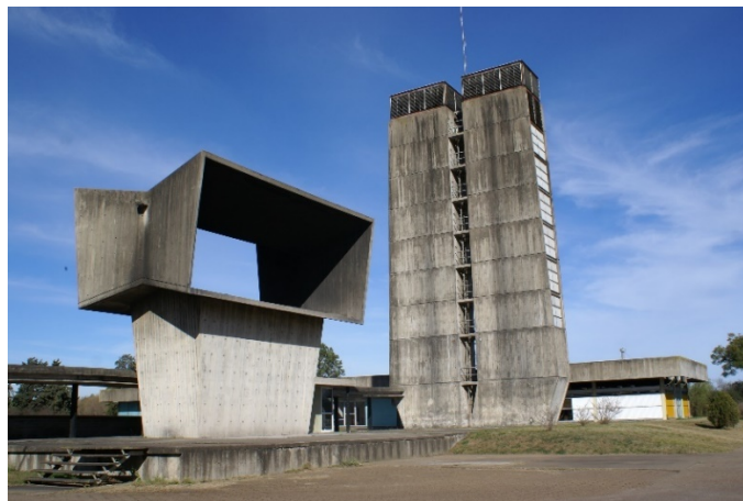
Figura 4 - Chimeneas de ventilación. Créditos: Foto Luis Müller
