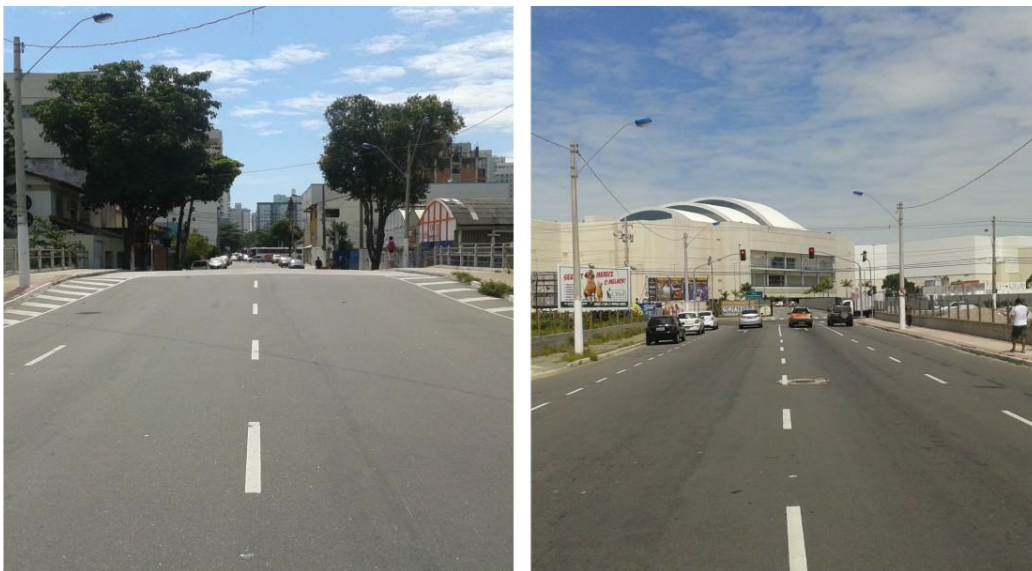
Figura 18 e 19: Obras da Rua Belém, que proporcionaram a ligação direta entre Itapoã (à esquerda) e o shopping (à direita) - Crédito da foto: Acervo do Autor
