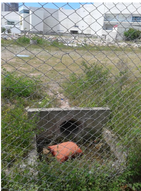
Figura 20: Caixas coletoras implantadas dentro do terreno do shopping, necessitam de manutenção constante
