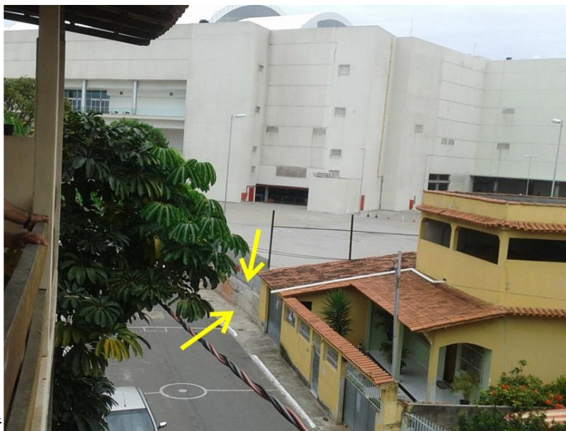
Figura 05: Desnível entre o pátio do shopping e a rua Ararê, fechada em sua Extremidade confrontante com o terreno do empreendimento - Crédito da foto: Acervo do Autor
