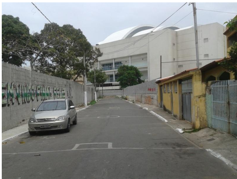
Figura 14: Rua Ararê, em seu trecho final, com limite ao terreno do shopping
