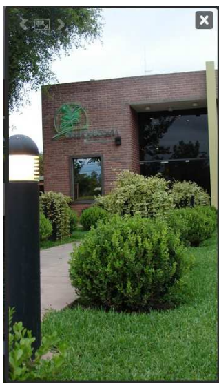
Figura 2. Entrada a las oficinas de la empresa en Las Lajitas.
